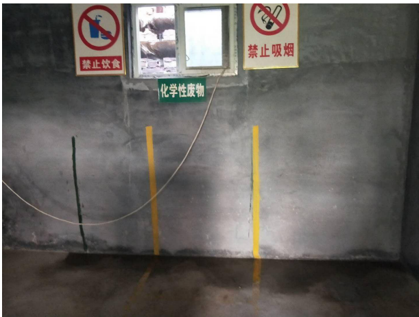
医疗废物暂存间（内部）
