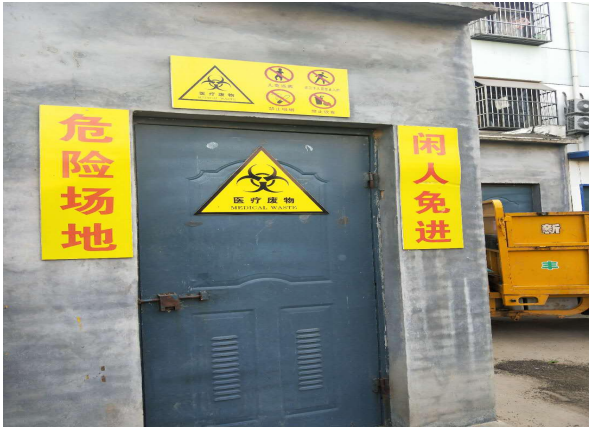
医疗废物暂存间（外部）
