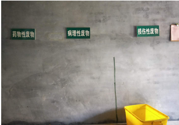
医疗废物暂存间（内部）
