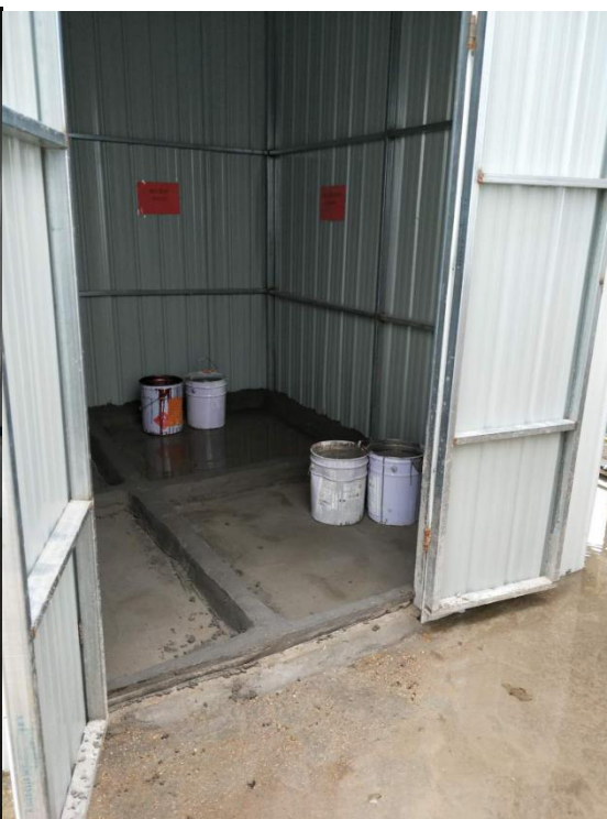
图为 3 号危废间围堰
