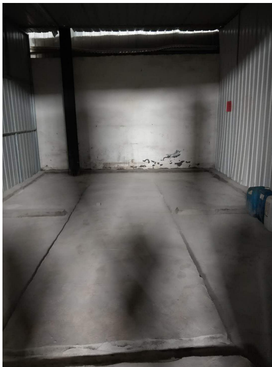
图为 2 号危废间围堰
